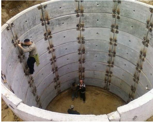
Рис. 1. Опускний колодязь
