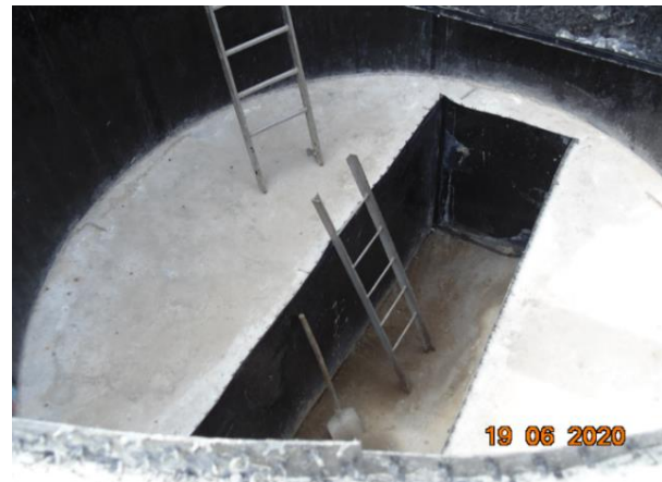
Рис. 4. Роботи з капітального ремонту шахти № 12 тунельного колектору 761 мікрорайону м. Харків
