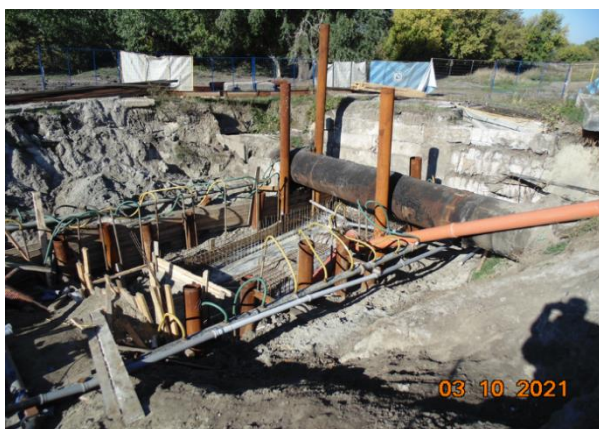
Рис. 5. Відновлювальні роботи Олексіївського колектору Ø 2000 мм біля оглядової камери № 33 на вул. Лопанській, м. Харків
